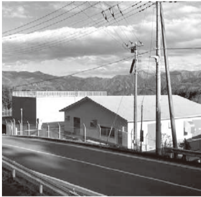
ミュージックパーク第2送水ポンプ場
