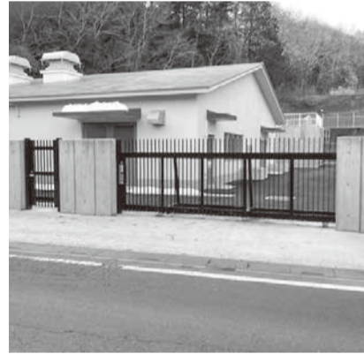
ミュージックパーク第1送水ポンプ場
