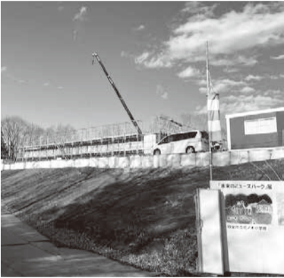
(仮称)新ミュージックパーク配水池
