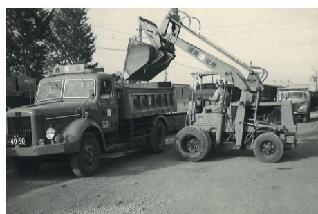
橋立浄水場の工事の様子 (S30～40年代)
