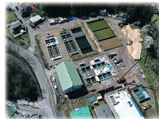
現在の橋立浄水場（令和6年4月）
