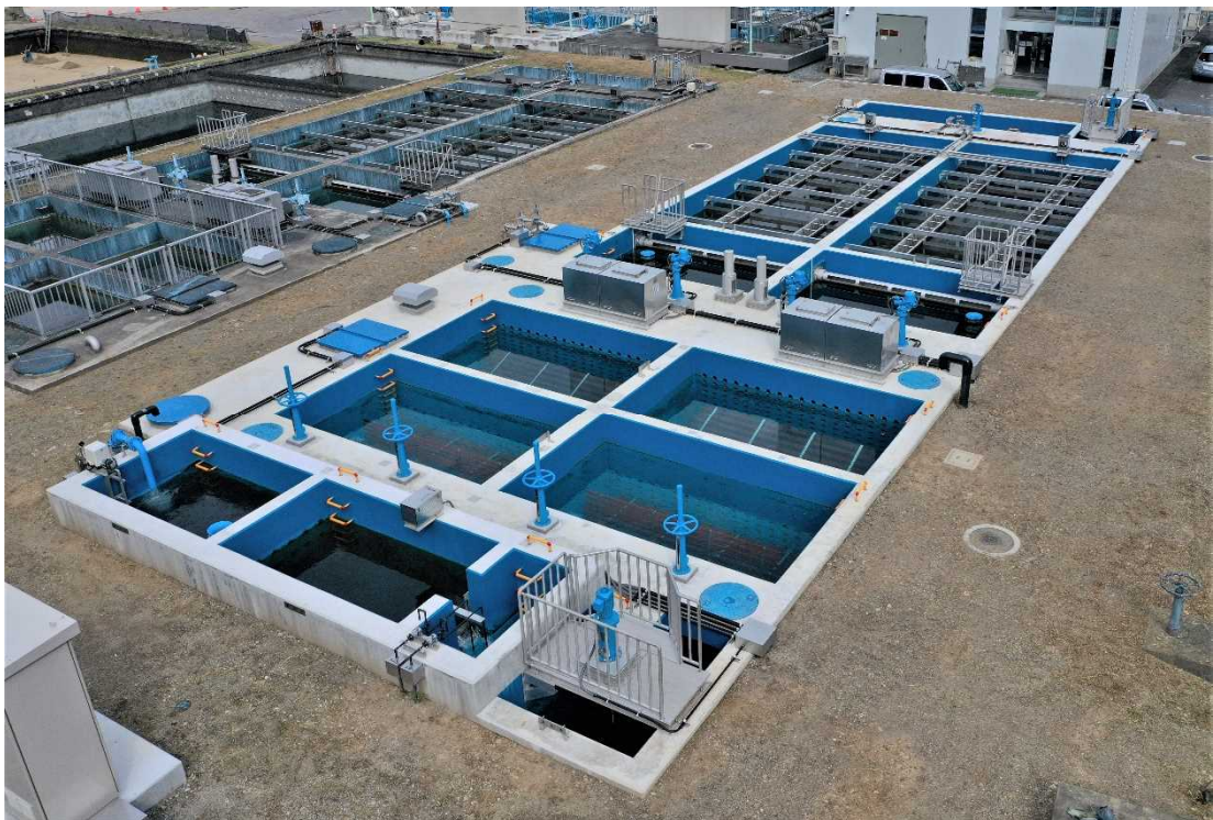
（橋立浄水場 薬品沈殿池（令和5年7月完成））
